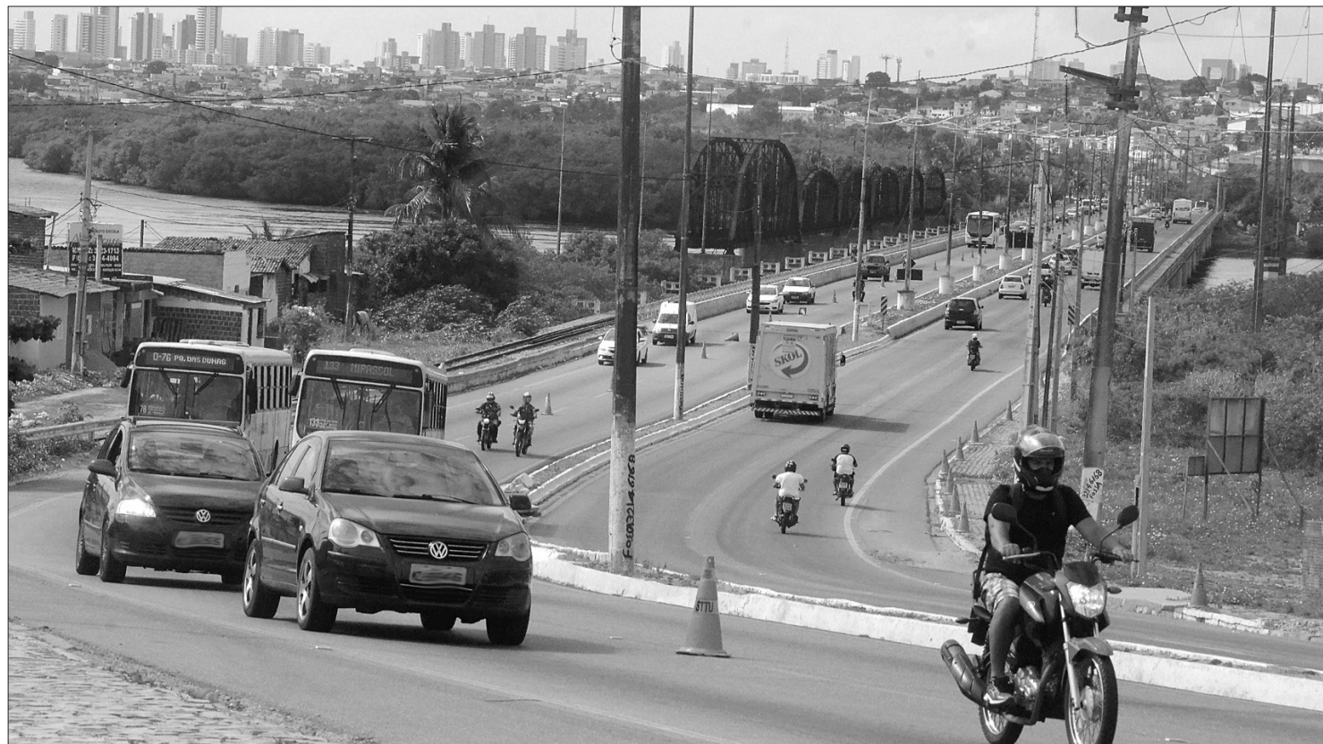
Inicialmente, equipamentos serão instalados em locais como a Ponte Newton Navarro, Salgado Filho, Prudente de Moraes e outros
