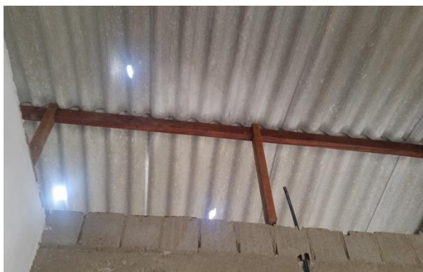
Foto 23 e 24 – telhas quebradas que serão substituídas.
