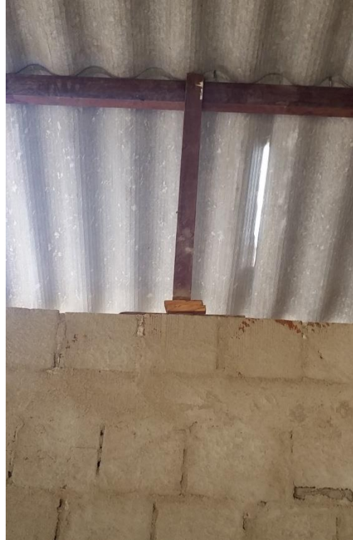
Foto 14 e 15 – ausência de base de apoio (berço) para estrutura pontalexada de madeira e base de apoio (berço) inadequada, respectivamente.
