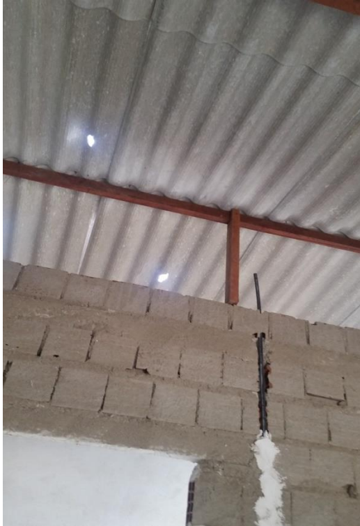
Foto 14 e 15 – ausência de base de apoio (berço) para estrutura pontalexada de madeira e base de apoio (berço) inadequada, respectivamente.
