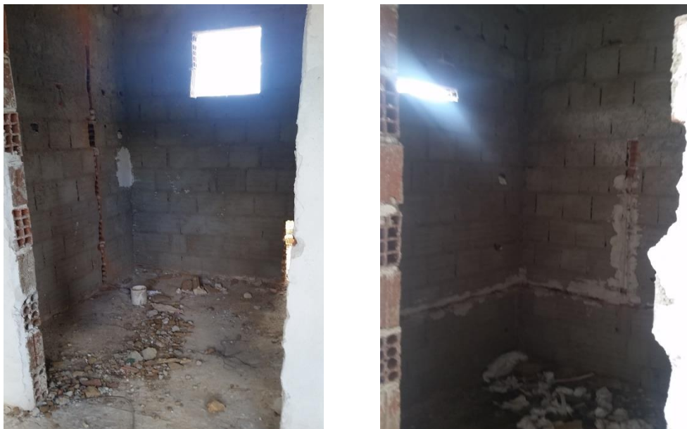
Fotos 27 e 28 - emboço em áreas molhadas que ainda não foram executadas.
