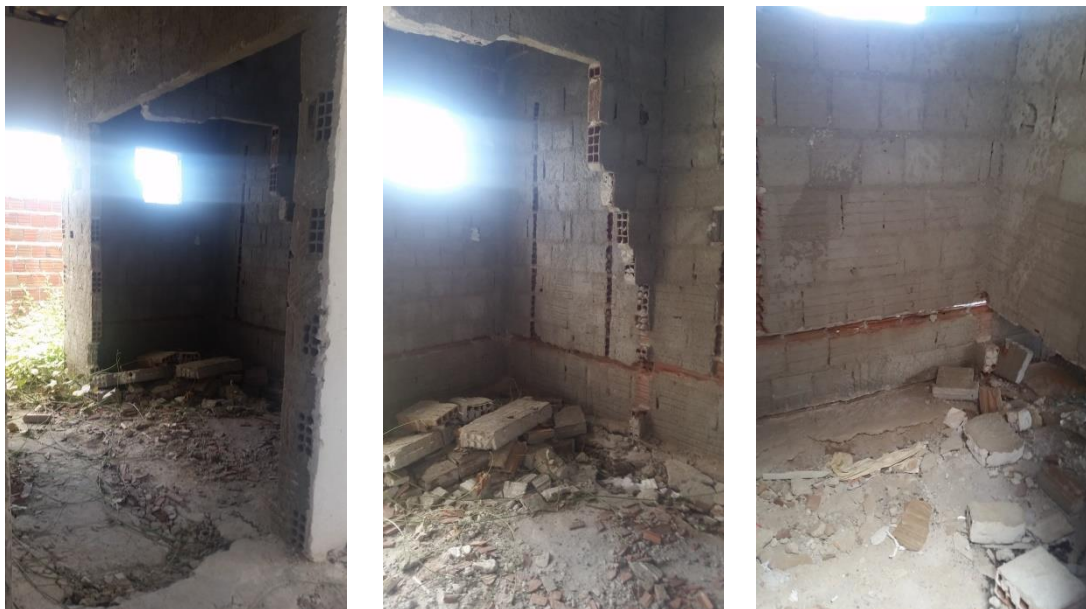
Foto 20, 21, 22 paredes a demolir
