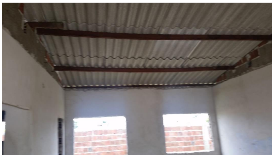
Foto 13 – retirada e troca de madeiramento da recepção, por perfil de madeira maior que o existente, devido a cobertura já está cedendo só com seu peso próprio.
